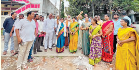
ఆందర్‌గ్రౌండ్ డ్రైనేజిపనులకు శ్రీకారం మడుతున్న కార్పొరేటర్ పుష్పనగేష్
